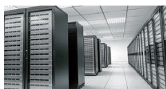
UPS A DATACENTRÁ
